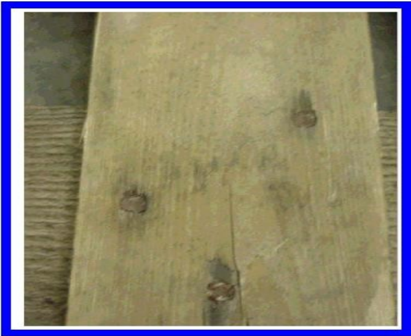
Гвозди полностью утоплены в доски (не выступают)
